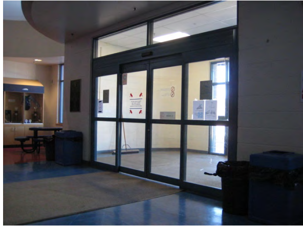
B2a Vestibule door and door mat
